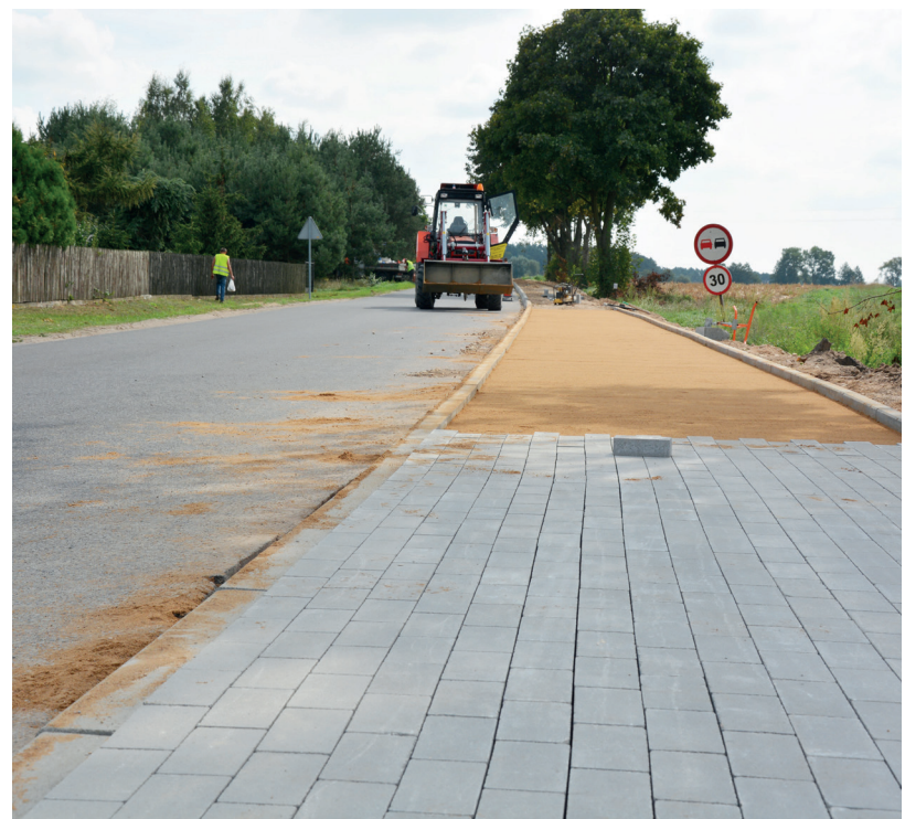
Na odcinku Smulsko - Boleszczyn powstaje nowy chodnik
