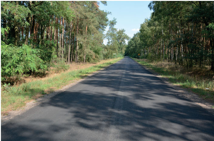
Odnowiona nawierzchnia drogi we Wróblinie
