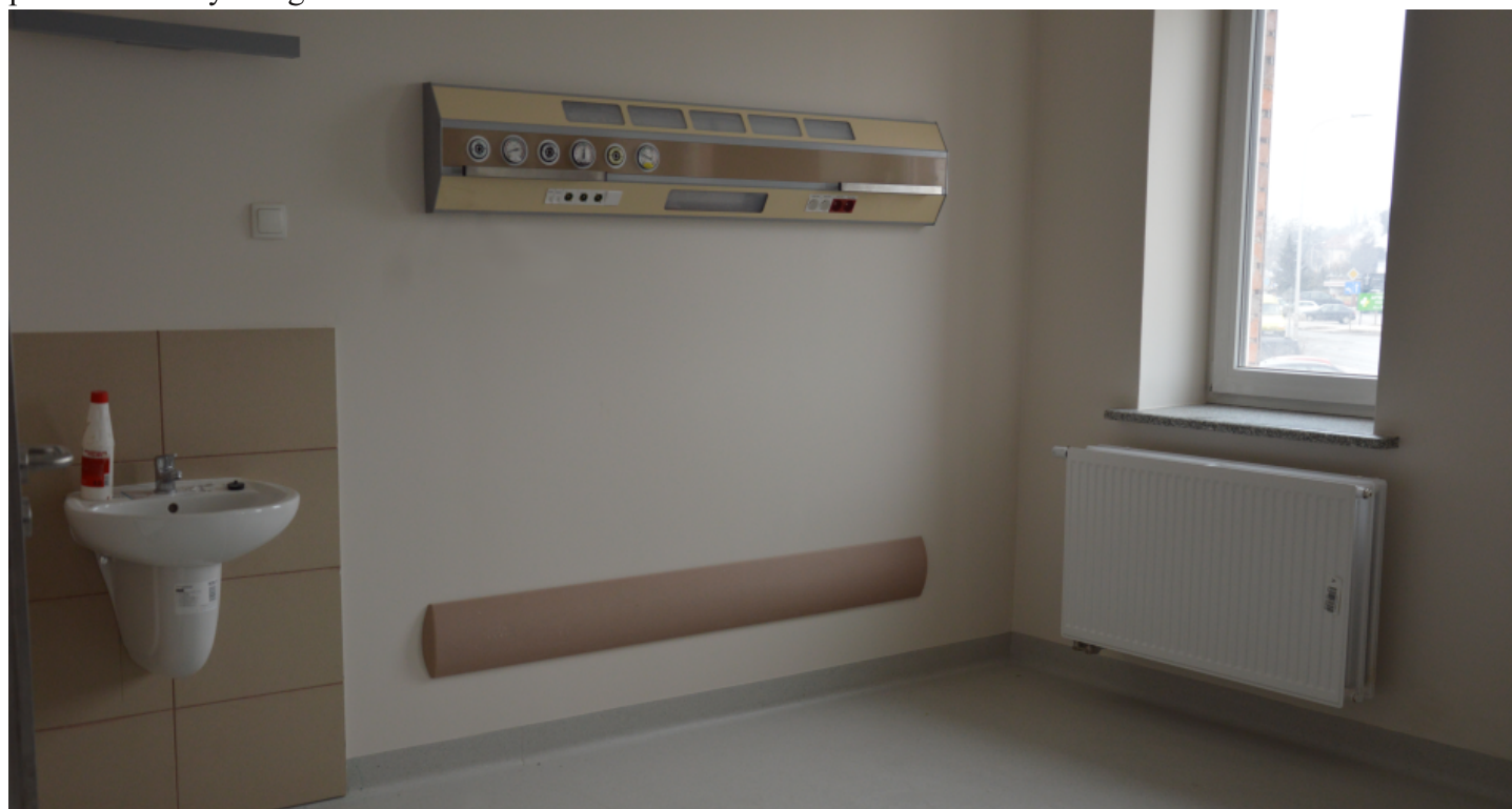
Sala dla chorych w nowo wyremontowanym oddziale
